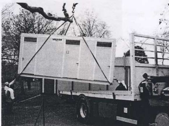
Pose de l'Algeco sanitaire
