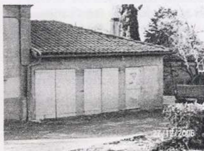
Bâtiment à détruire intégrant l'ancienne chaufferie et les sanitaires
