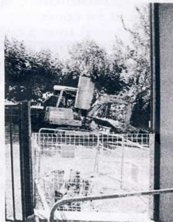
Pose de la pompe de relèvement à l'école primaire
