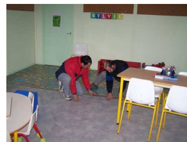
Préfabriqués rénovés par le personnel des ateliers
